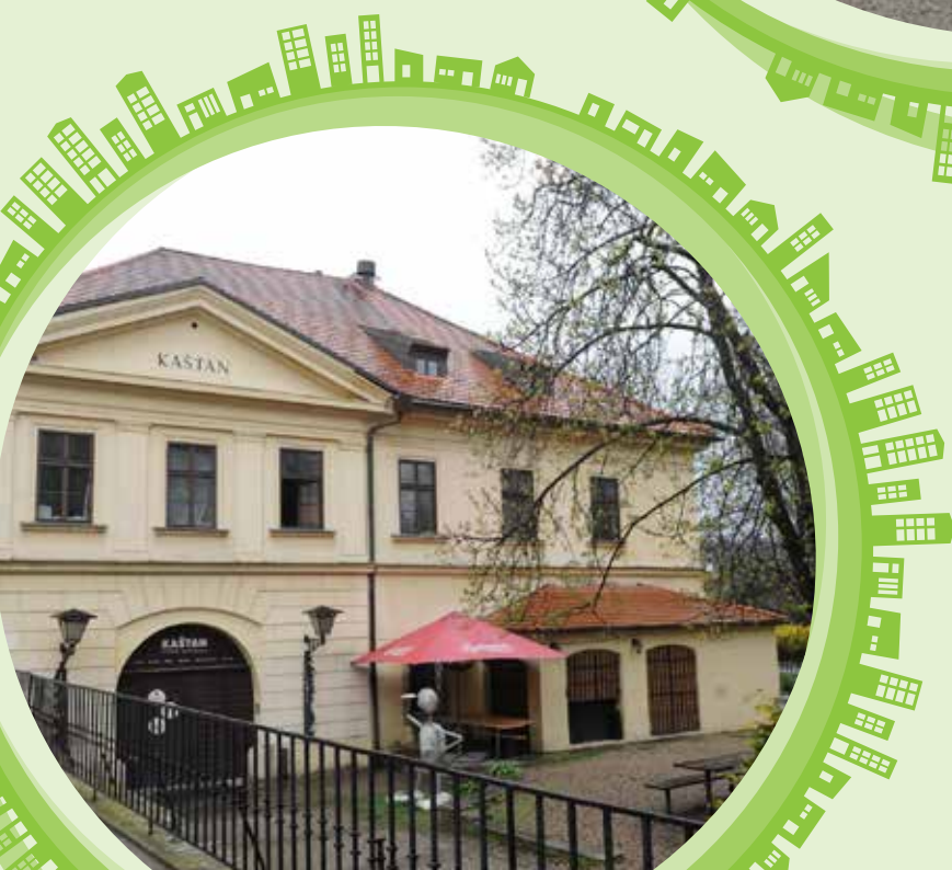
kulturní centrum Kaštan
