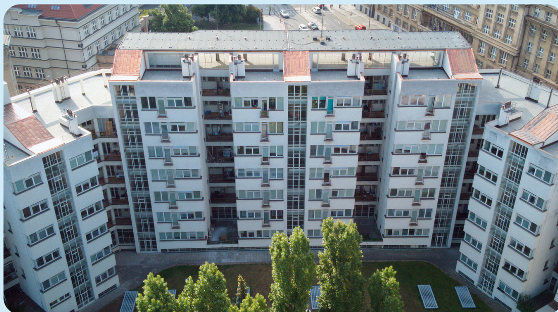
Skleněný palác (bytový dům náměstí Svobody 728/1)
