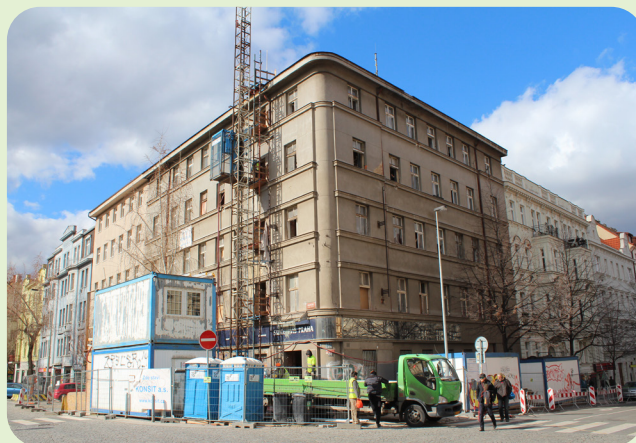
bytový dům Dejvická 184/4
